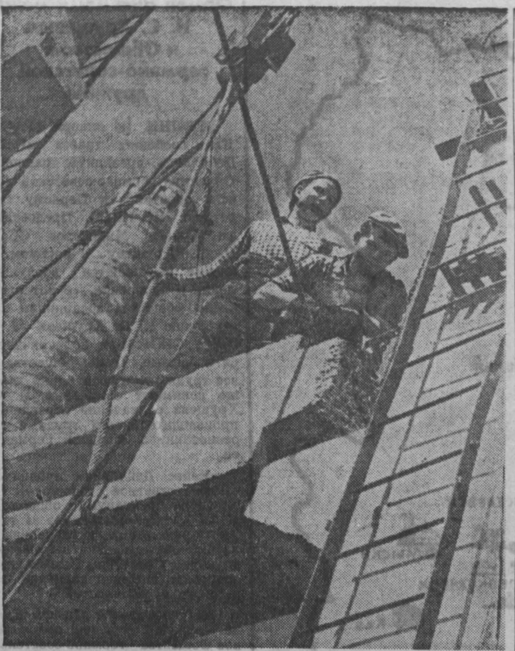
На строительстве Белоусовской ГРЭС трудится замечательная бригада монтажников-высотников, возглавляемая Георгием Аркадьевичем Матроскиным. На их долю выпала большая ответственность — возвести из сборного железобетона корпуса станции.
